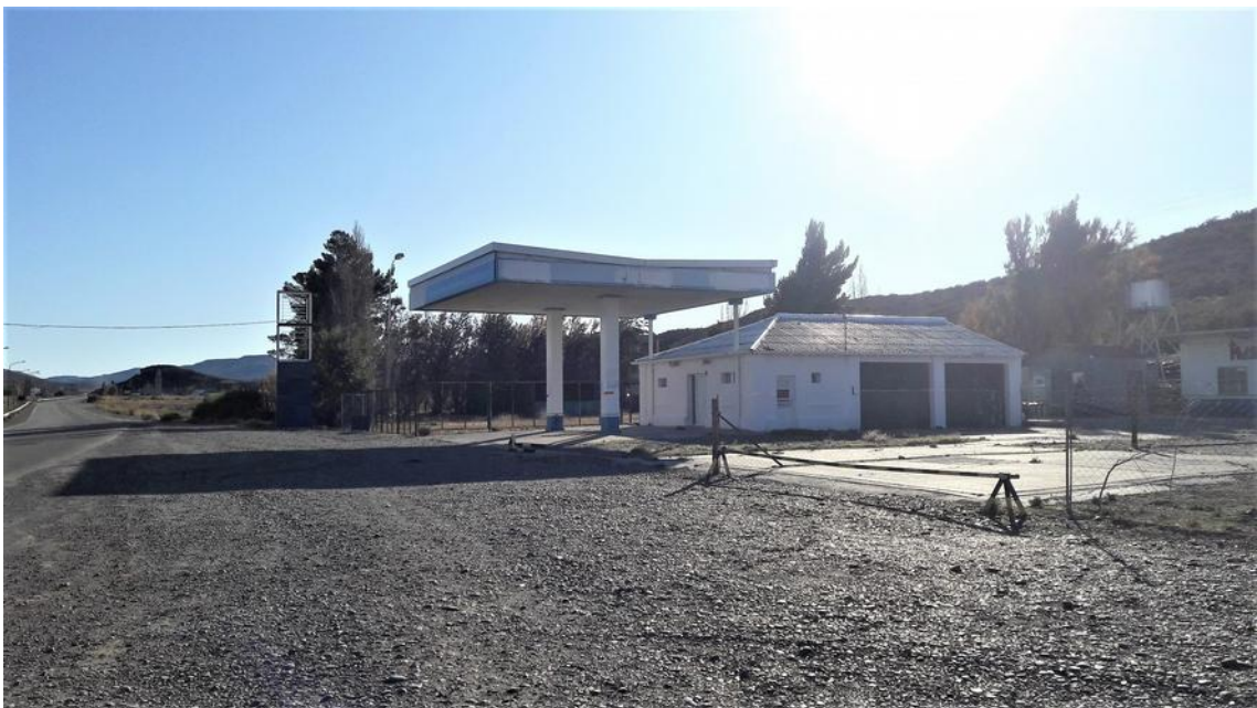
Foto 3: Vestigios de la Estación de servicio de Shell en Diadema tomada por la autora, 2020.
