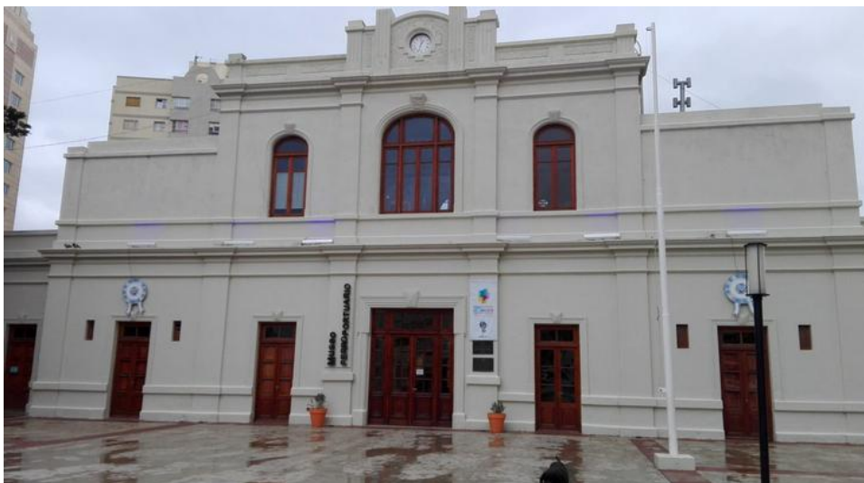
Foto 3: Fachada actual de la estación de ferrocarril edificio del Museo Ferroportuario. Fuentes: Frente y contrafrente AHMCR en la década del 20, actual portada de Municipio CR.
