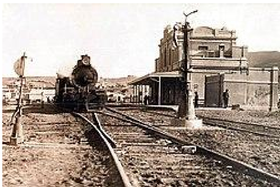
Frente y contrafrente de la estación del ferrocarril
